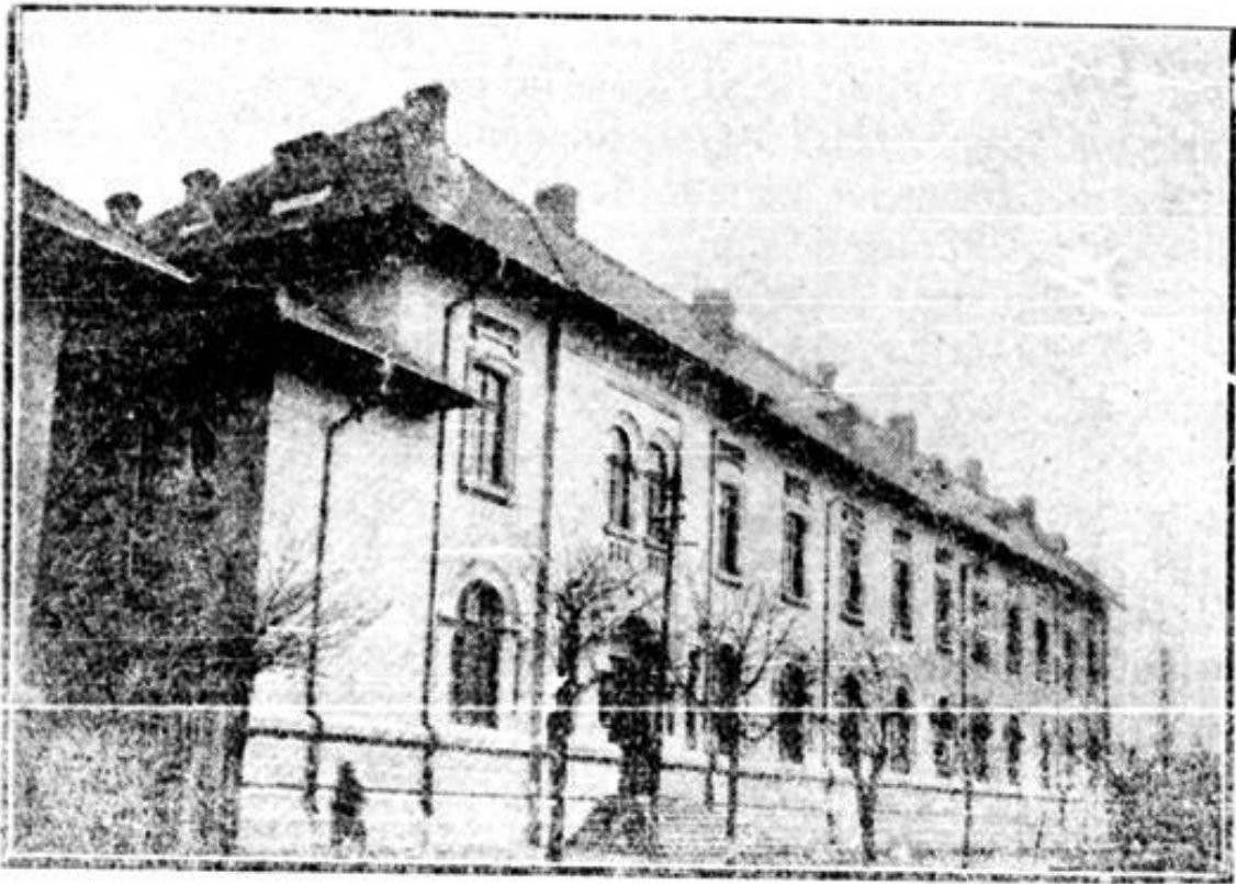
ARIPA TERMINATĂ A NOULUI LOCAL. FAȚADA SPRE STR. MIRCEA CEL MARE.
